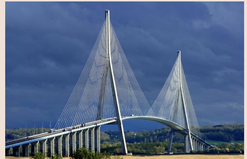
Pont de Normandie
